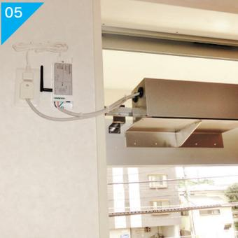
窓開閉器制御装置
